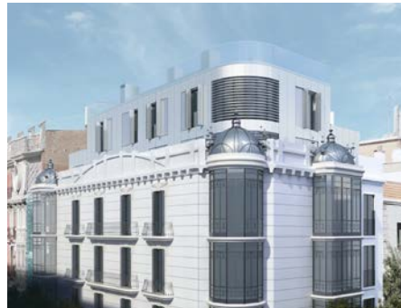
Rehabilitación Edificio C/Ayala 63 ( Madrid ). GLOBAL ENDOR
